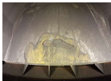
機器内部ケーシング点検
