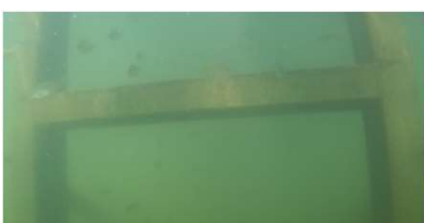
貯水池構造物点検
