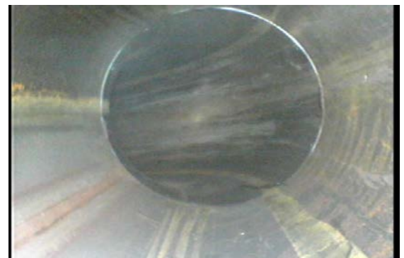
配管内面画像
