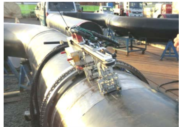
配管探傷状況
