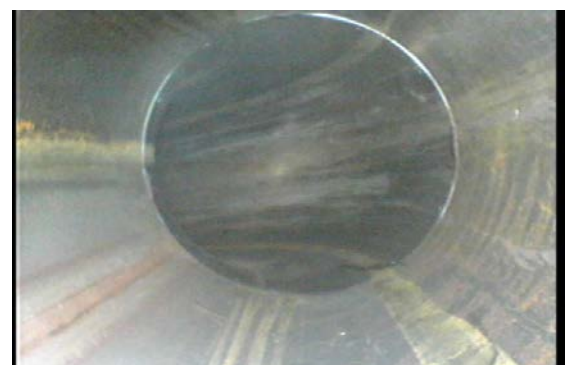
配管内面画像
