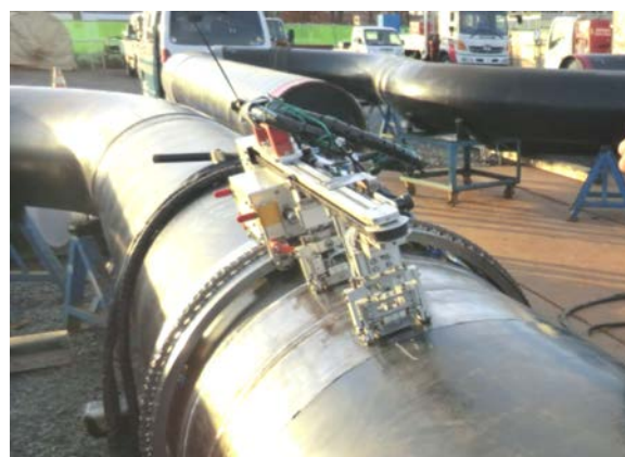
配管探傷状況
