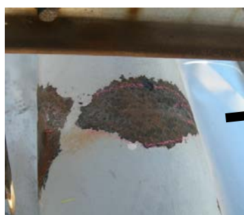
配管バンド部腐食状況
