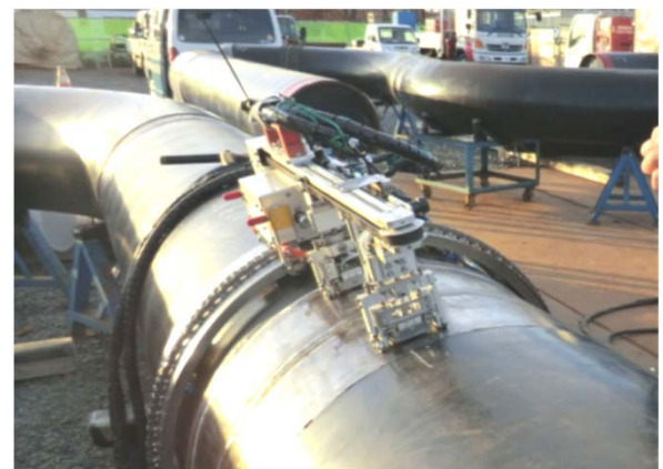
配管探傷状況
