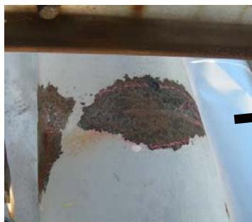
配管バンド部腐食状況
