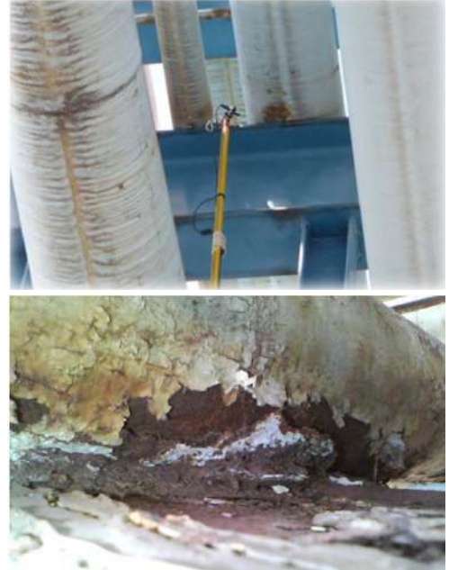
スケール付着による外面腐食の懸念
