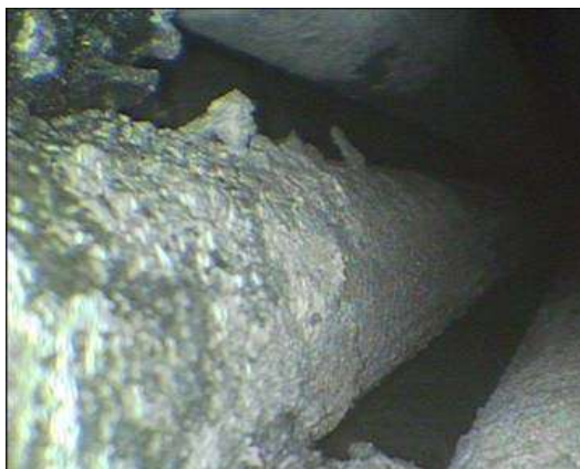
装置内スケール堆積状況確認例
