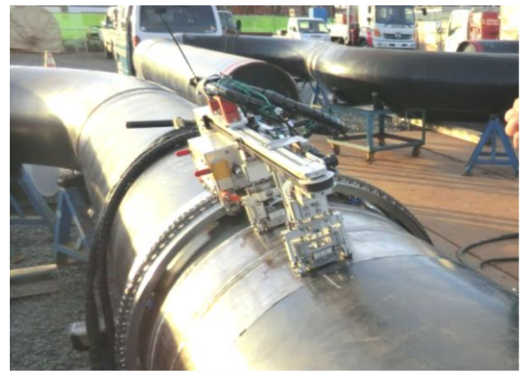
配管探傷状況
