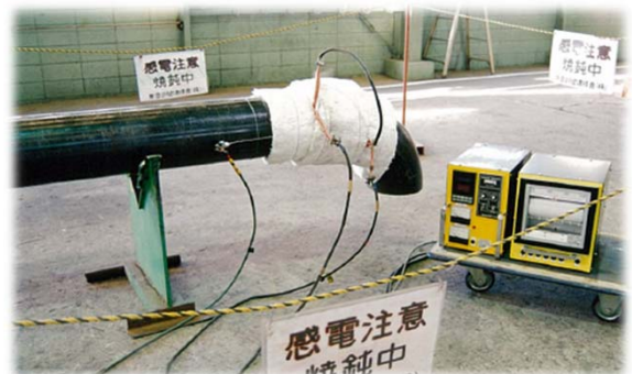
配管溶接部の局部熱処理状況
