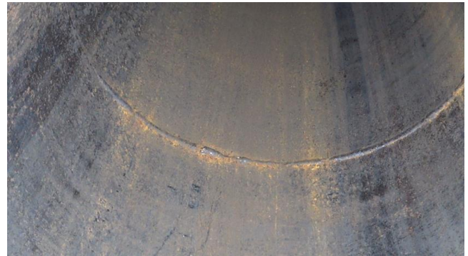
300 A配管内部溶接部撮影画像
